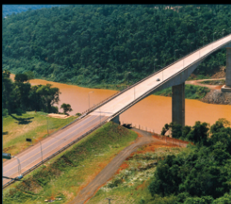
PUENTE INTERNACIONAL TANCREDO NEVES
