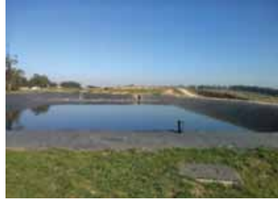
- Vista lagunas de acopio y tratamiento anaeróbico de lixiviados.
