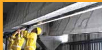
REPARACIONES Y REFUERZO
