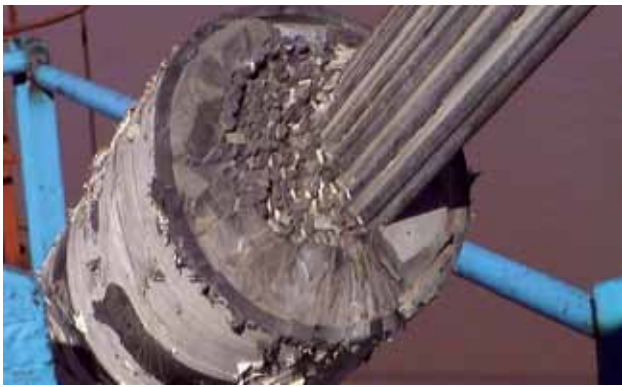
- ARRIBA. El operador va cortando la protección del cable. - ABAJO. El cable ya pelado, con la lechada de cemento.
