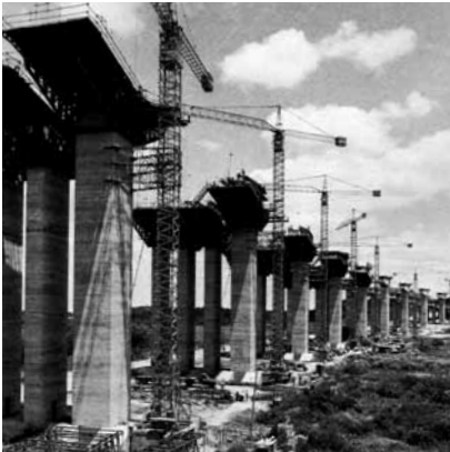
– ESTRUCTURAS DE ELEVACIÓN: ejecución de cantilevers.
