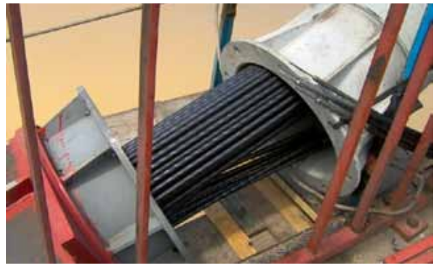
- ARRIBA. Se colocan aros de alambre para evitar chicotazos. - ABAJO. Cables nuevos para ser colocados y calibrados.
