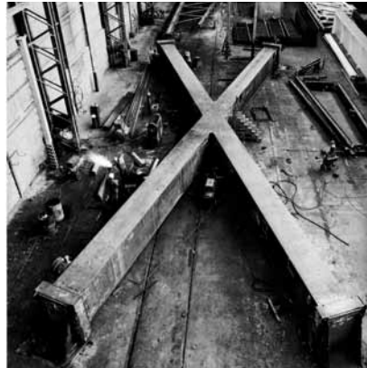
– FABRICACIÓN DE ESTRUCTURAS: cruz entre torres concluída.
