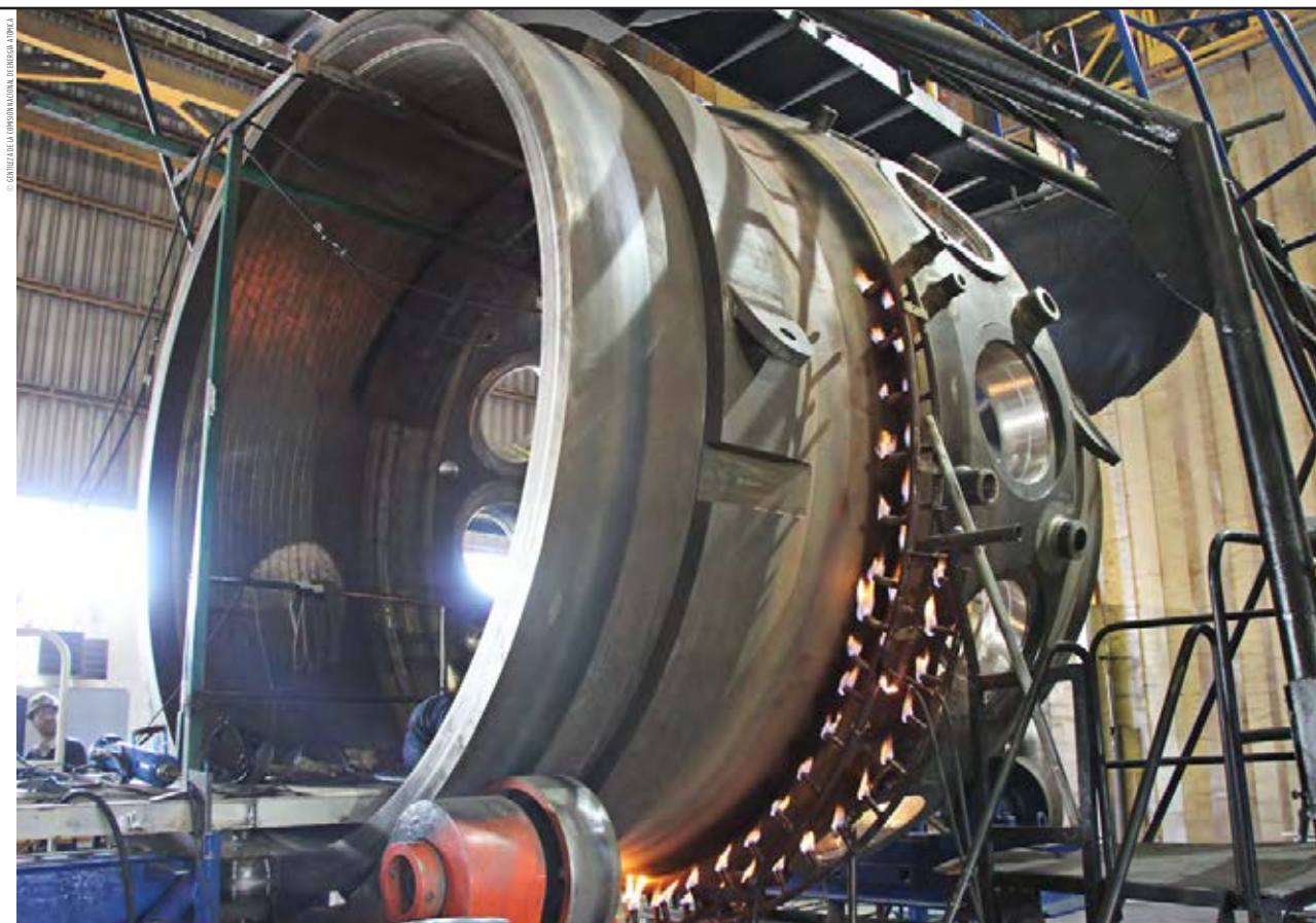
-MENDOZA. La empresa IMPSA, en Mendoza, se encuentra realizando el ensamblado de cada una de las piezas de acero para crear el recipiente que contendrá al núcleo, el corazón de la central nuclear CAREM 25.
