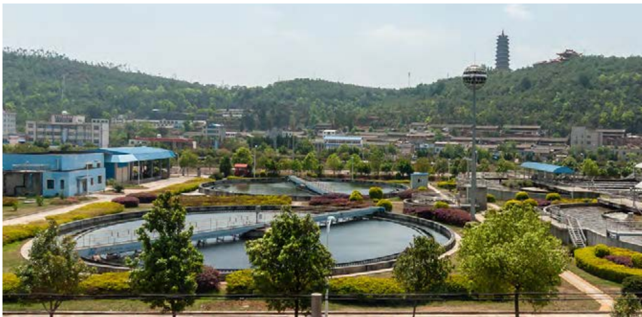
-CHINA. Chuxiong, Yunnan - La planta de tratamiento de agua de Chengjiaba.
