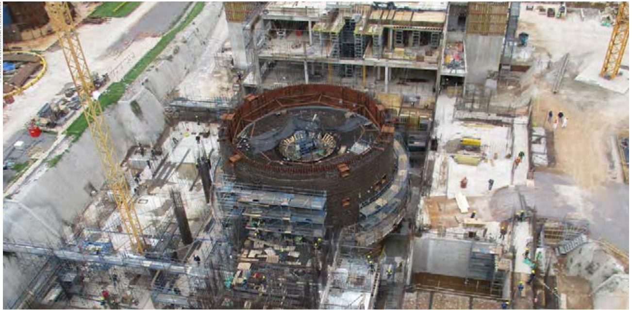
-VISTA AÉREA. La obra a fines de octubre de 2019, la construcción del edificio que contendrá al núcleo, las barras estabilizadoras de temperatura, la cúpula de acero y los sistemas de seguridad.
