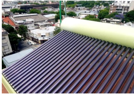
Instalación de energía solar térmica termosifónica no presurizada Edificio en propiedad horizontal destino vivienda en CABA
