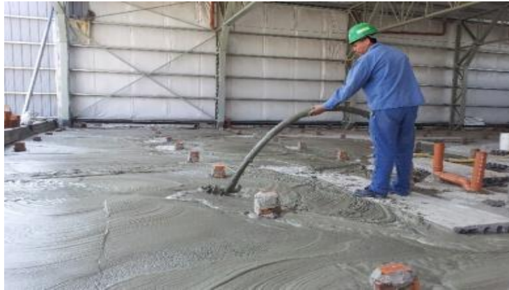
Bombeo de contrapiso y carpeta monocapa de hormigón celular de baja densidad
