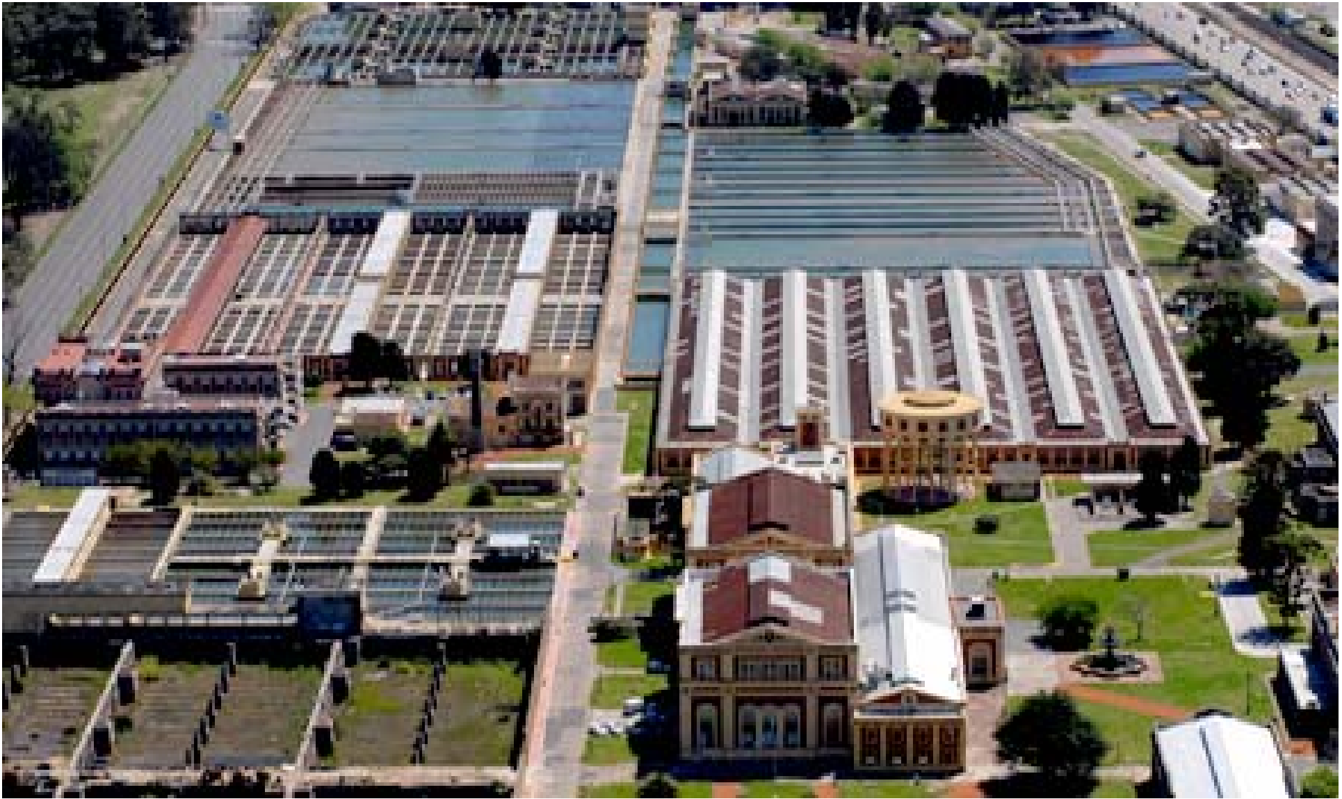
Planta potabilizadora General San Martín
