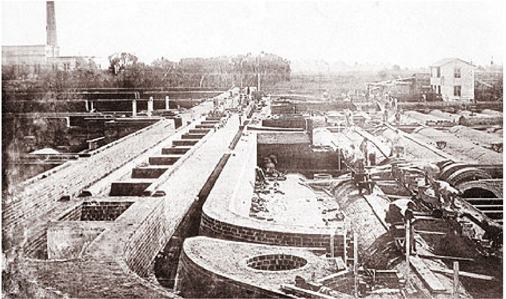
Construcción de la planta de purificación del Establecimiento Recoleta
