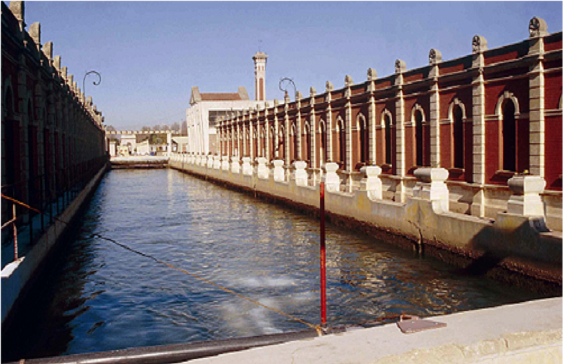
Planta potabilizadora General San Martín
