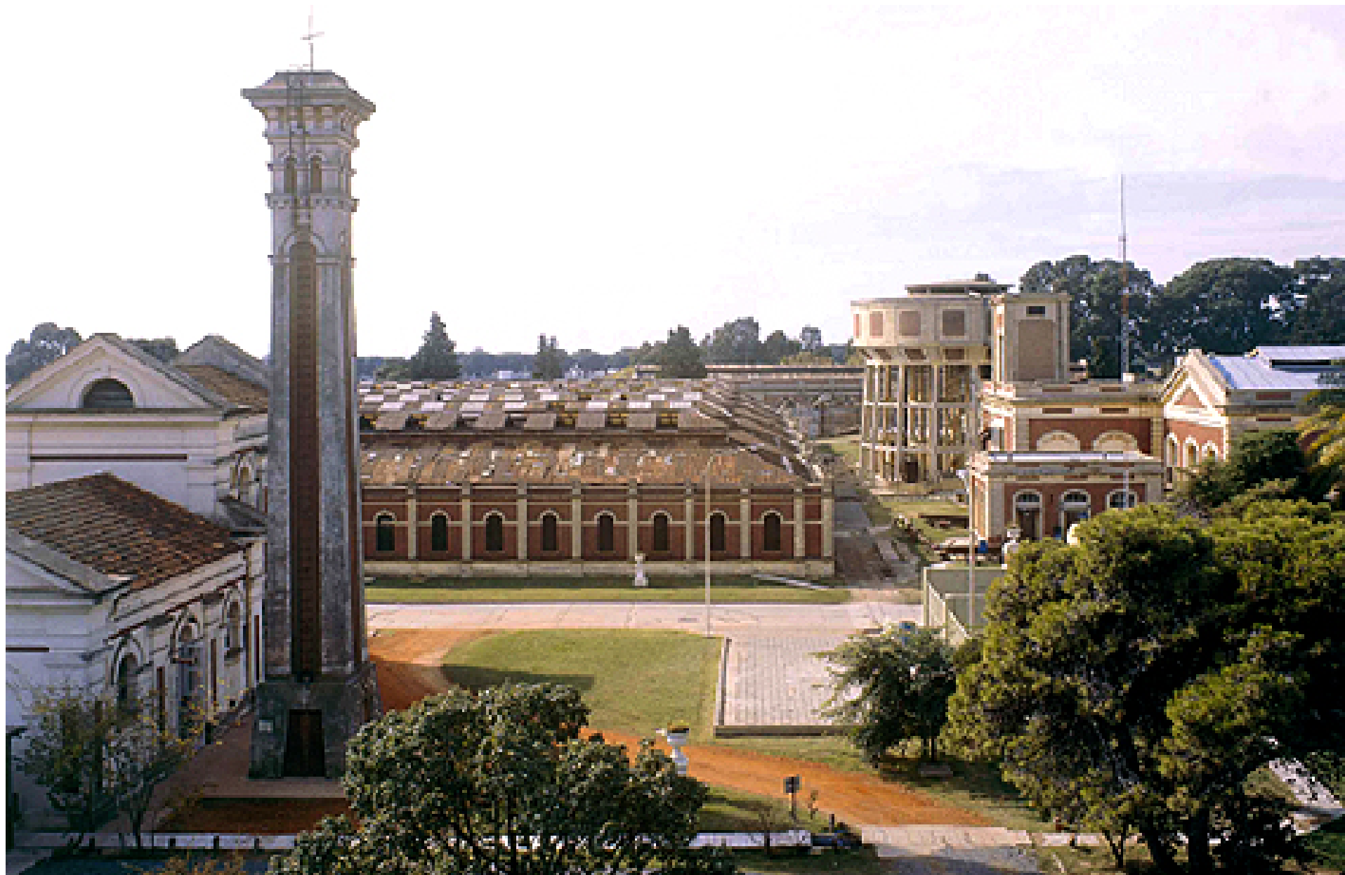
Planta potabilizadora General San Martín
