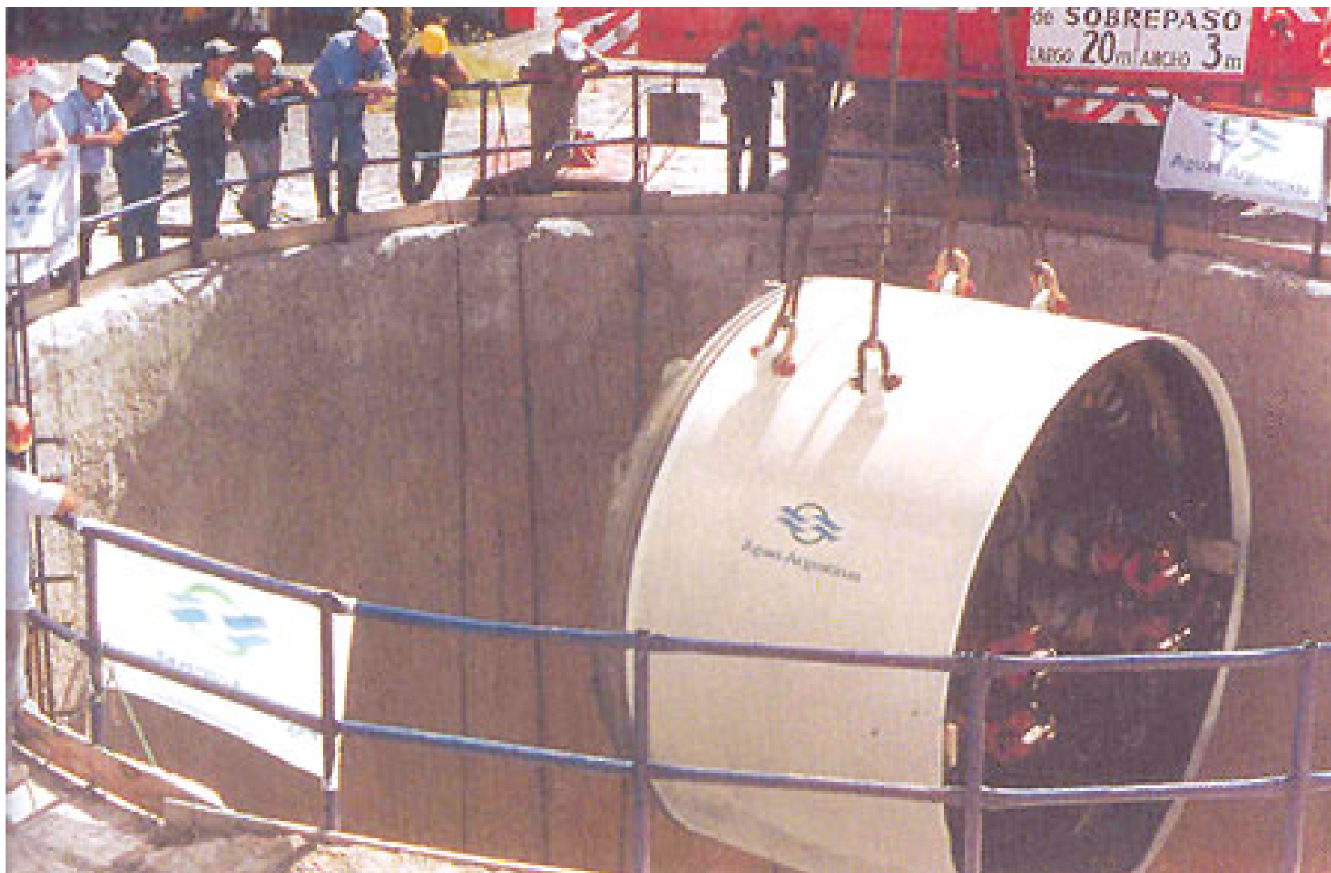
Finalización de la construcción del río subterráneo Saavedra-Morón Momento en el que es sacada a la superficie la cabeza de la segunda máquina tunelera
