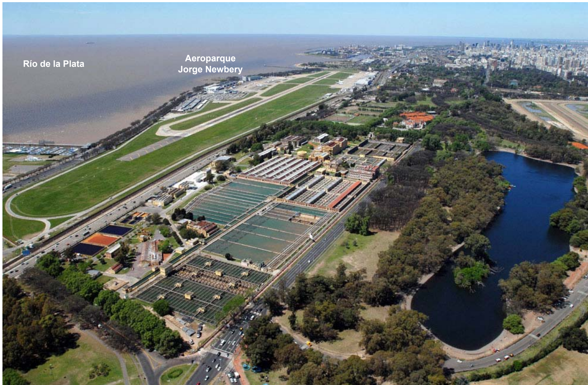
Planta Potabilizadora General San Martín Vista aérea actual del Establecimiento Palermo
