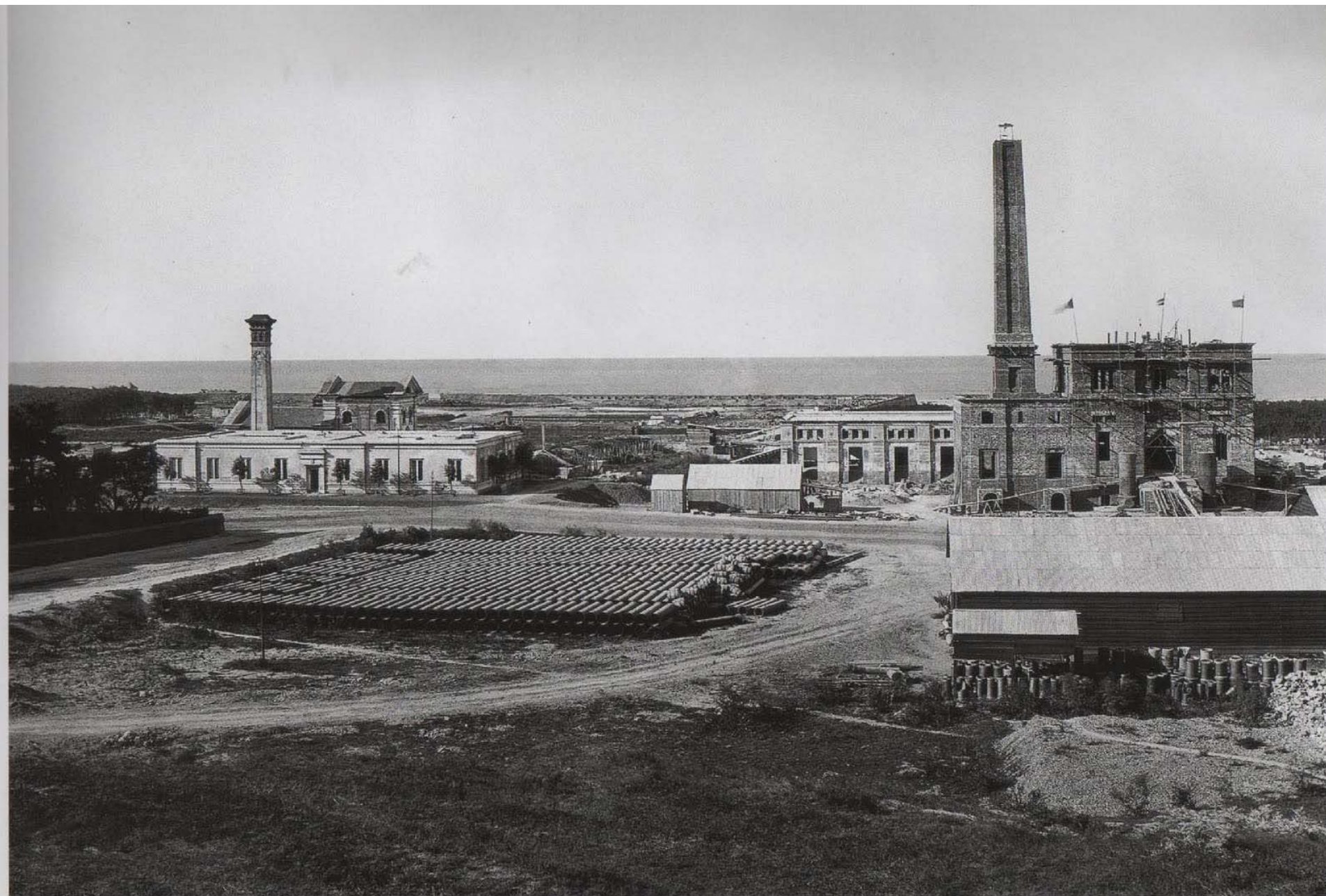
Instalaciones del servicio de agua potable en el bajo de la Recoleta, atribuida, ca.1875. Negativo al colodión, 237mm x 298mm. Las primeras instalaciones fueron inauguradas el 1874 y ampliadas cuatro años después. En la foto se ve la ampliación casi concluida. Se trata del emplazamiento del actual museo nacional de Bellas Artes. Archivo General de la Nación.
