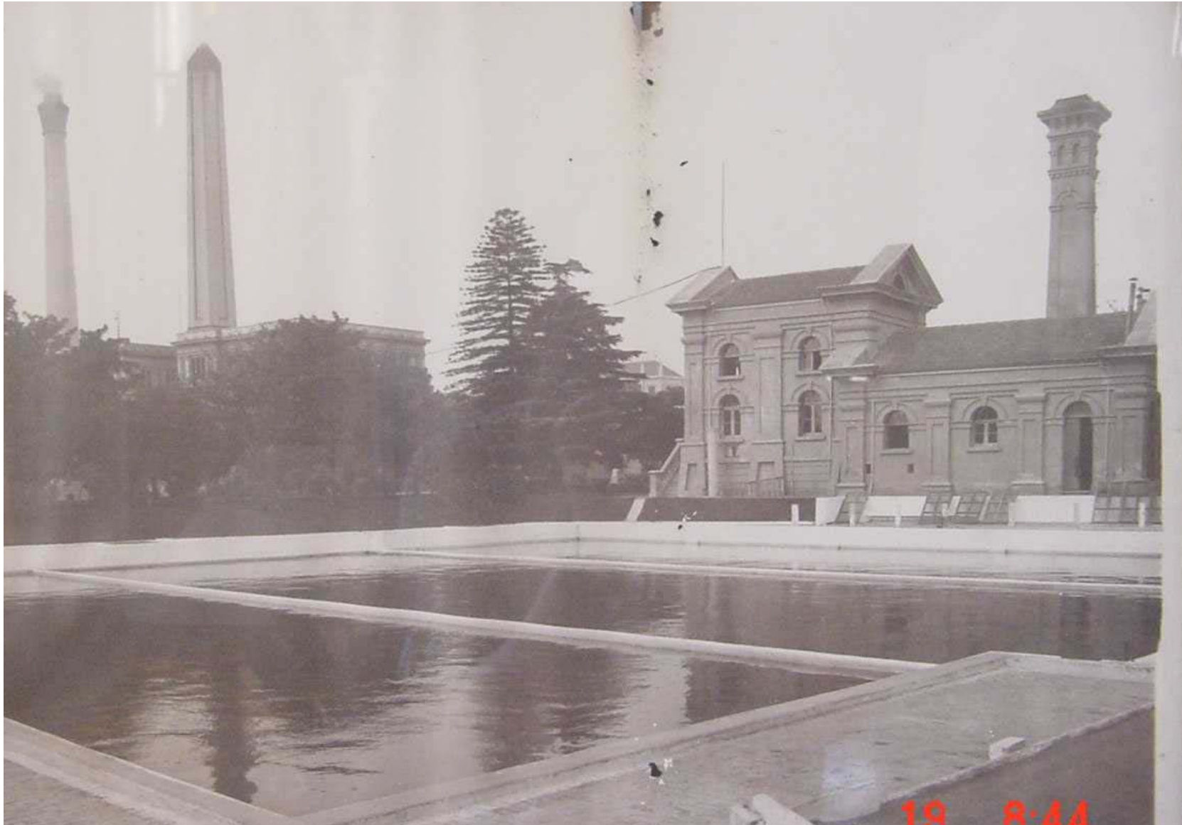
Establecimiento Potabilizador Recoleta Vista de la Primera Casa de Bombas
