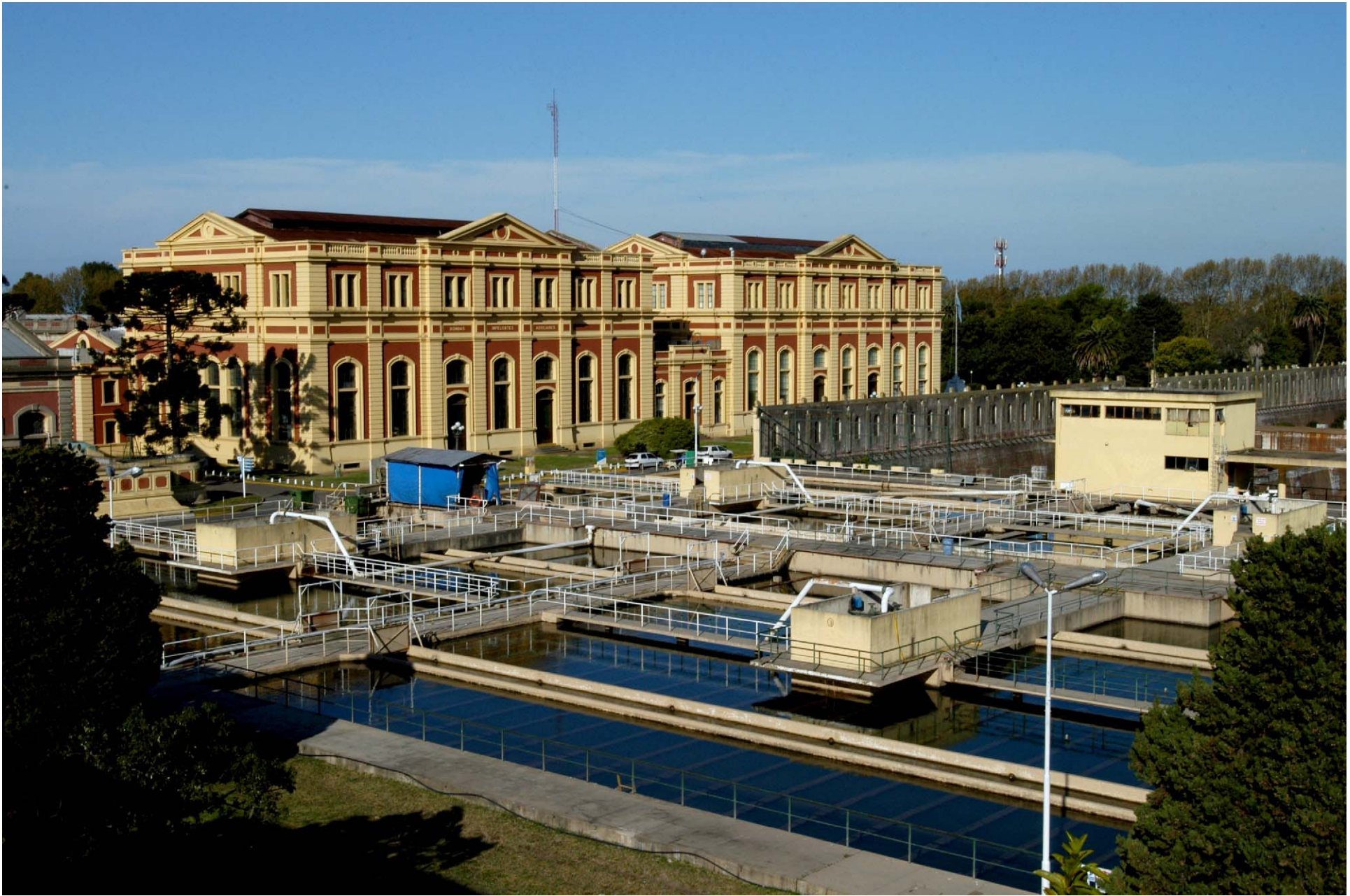
Planta potabilizadora General San Martín
