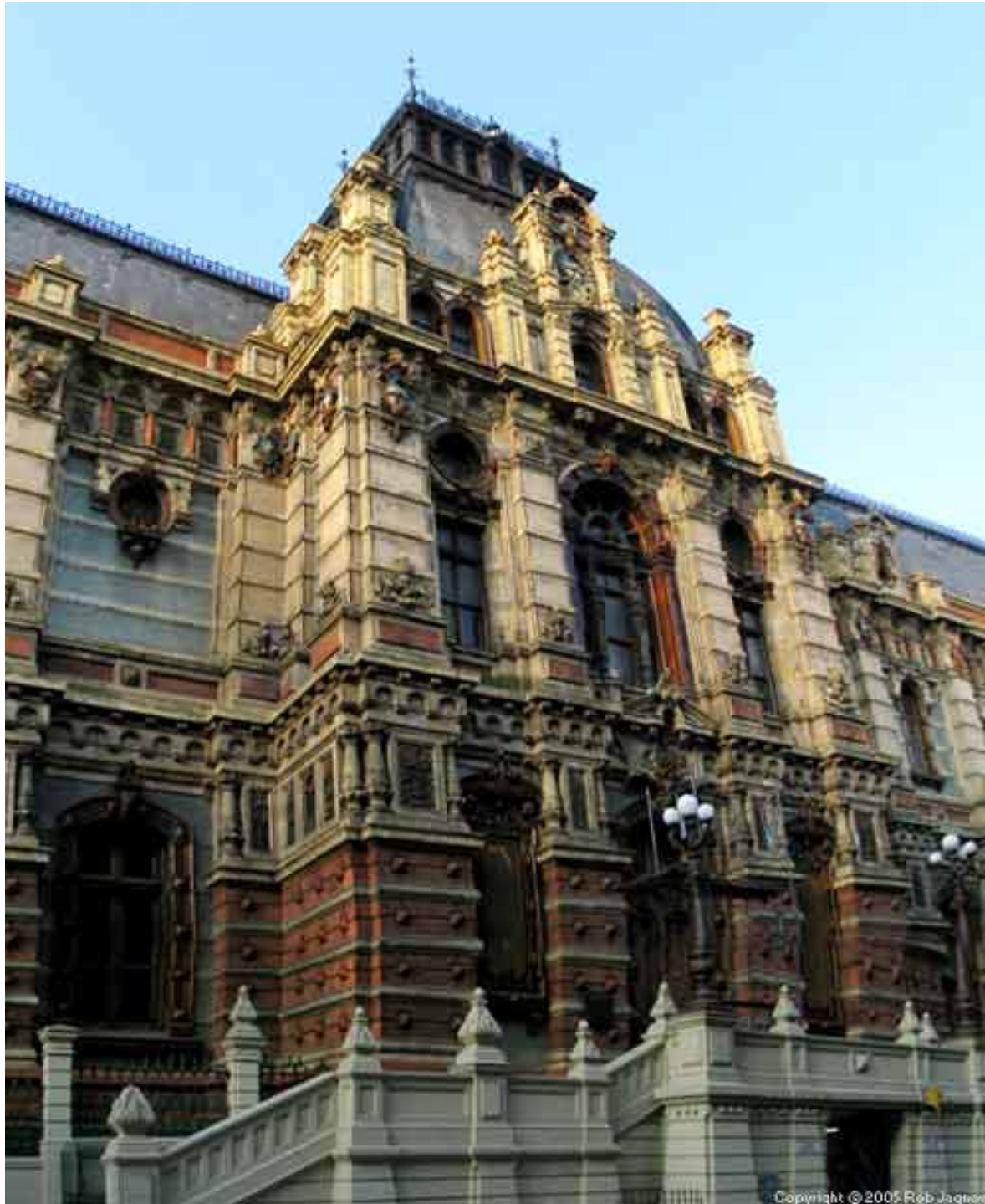
Palacio de las Aguas Corrientes Fachada y entrada principal Declarado Monumento Histórico Nacional en 1987
