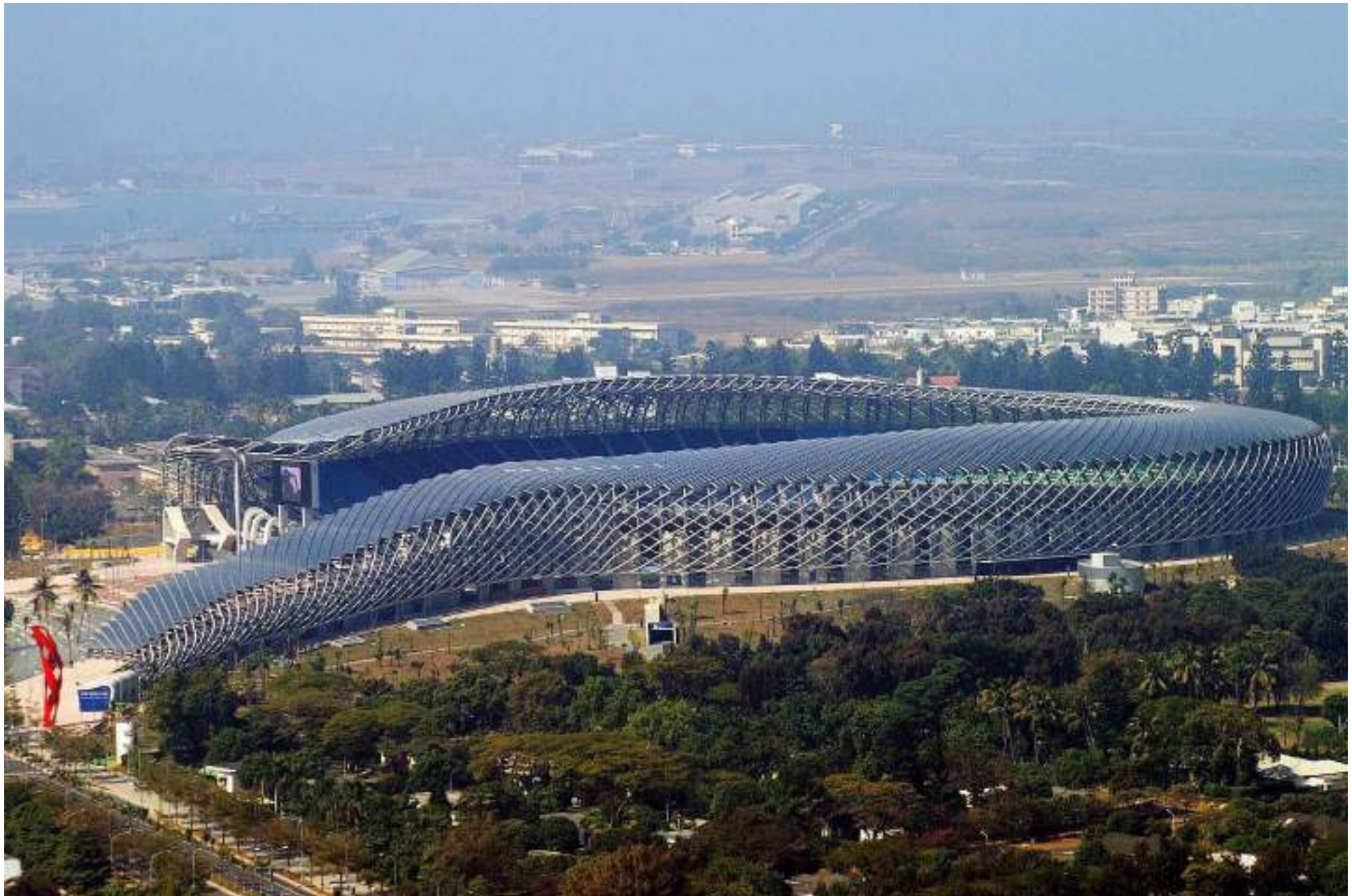
CUBIERTA FOTOVOLTAICA DEL ESTADIO NACIONAL DE KAOHSIUNG, TAIWAN Sede de los Juegos Mundiales de 2009
