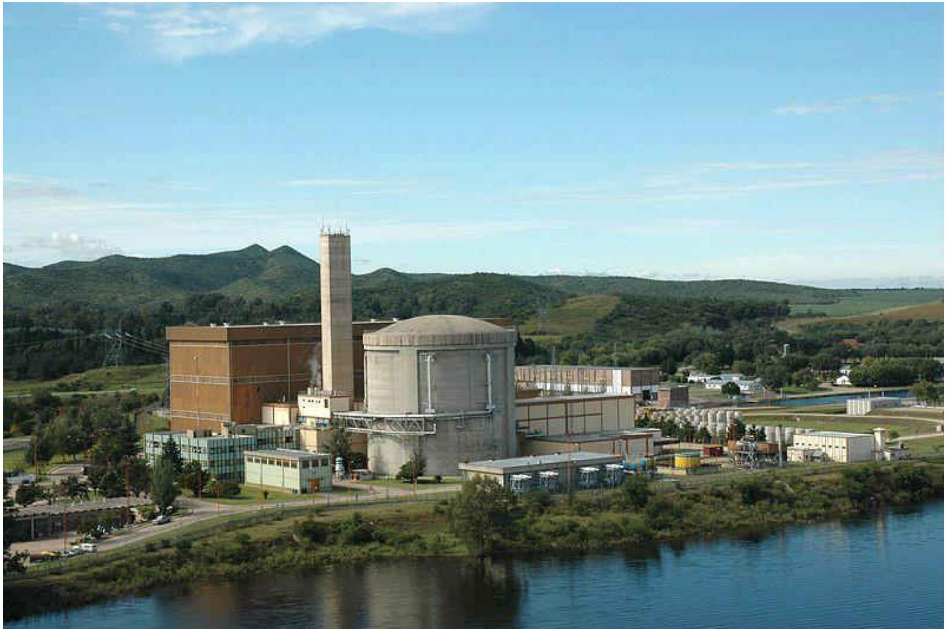
CENTRAL TÉRMICA DE COMBUSTIBLE NUCLEAR EN EL EMBALSE DEL RÍO III Provincia de Córdoba, ARGENTINA 648 MWe
