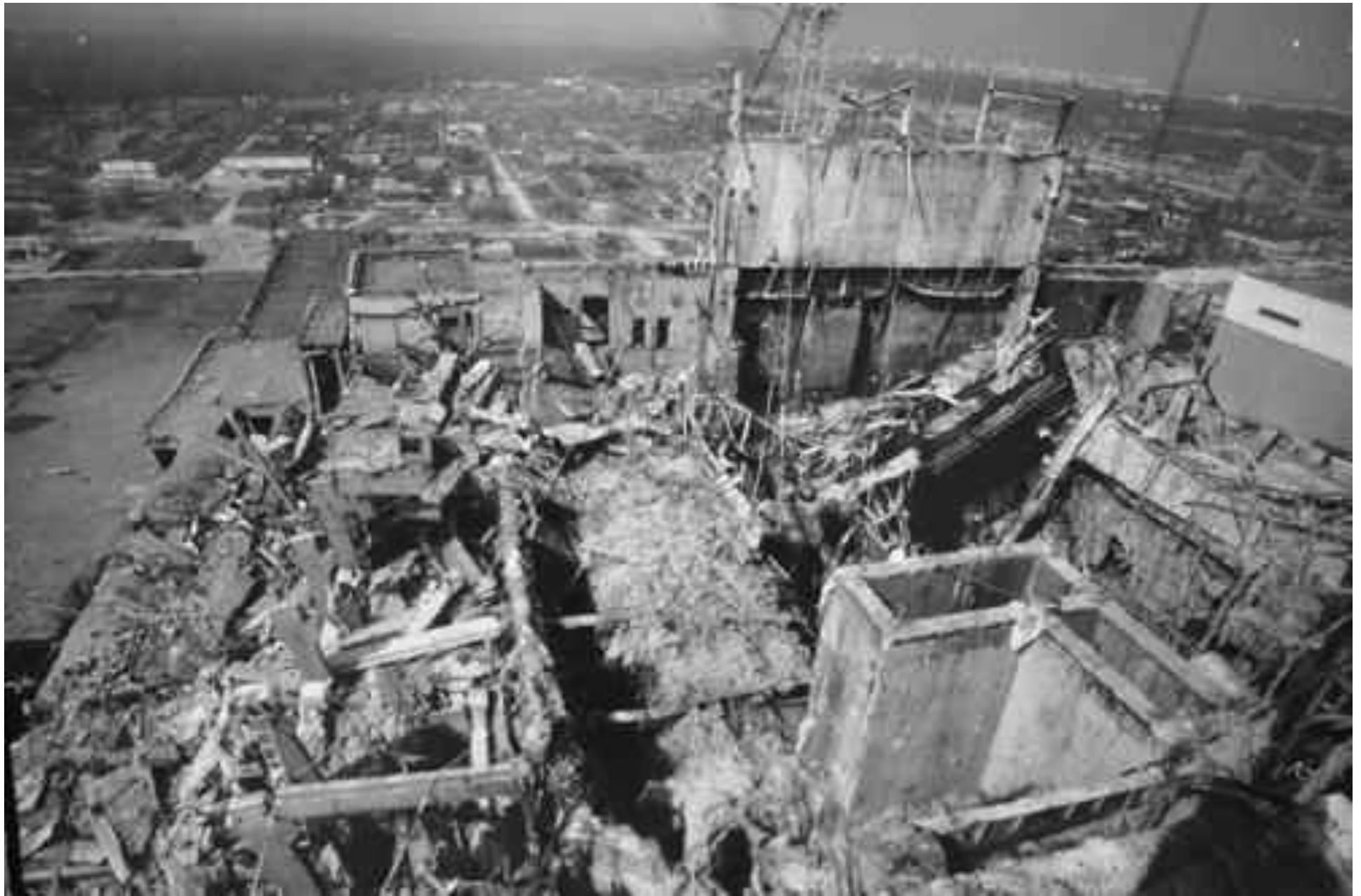
EFFECTOS DE LA EXPLOSIÓN EN EL REACTOR N° 4 26 de abril de 1986
