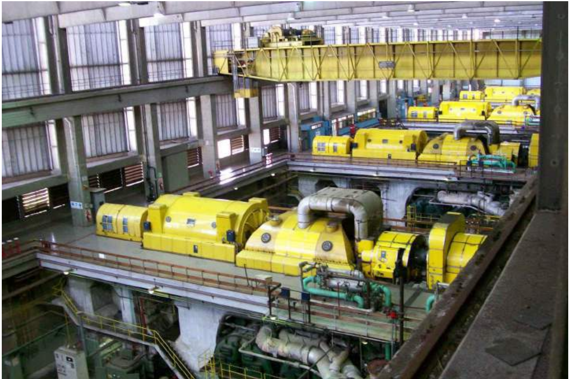
CENTRAL TERMOELÉCTRICA COSTANERA TURBOGRUPOS BRITISH THOMSON-HOUSTON DE 120 MW CADA UNO
