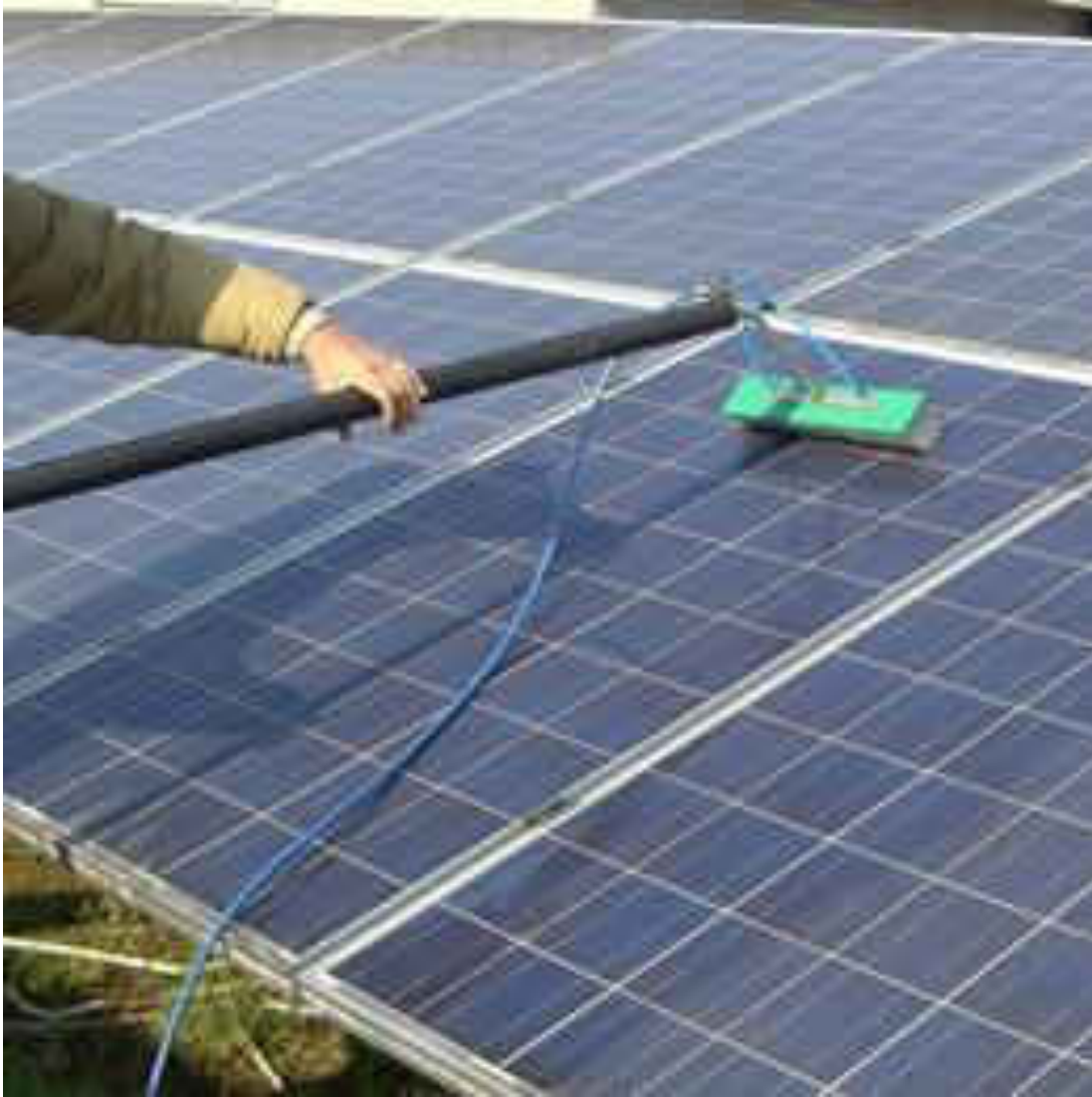
LIMPIEZA DE PANELES SOLARES
