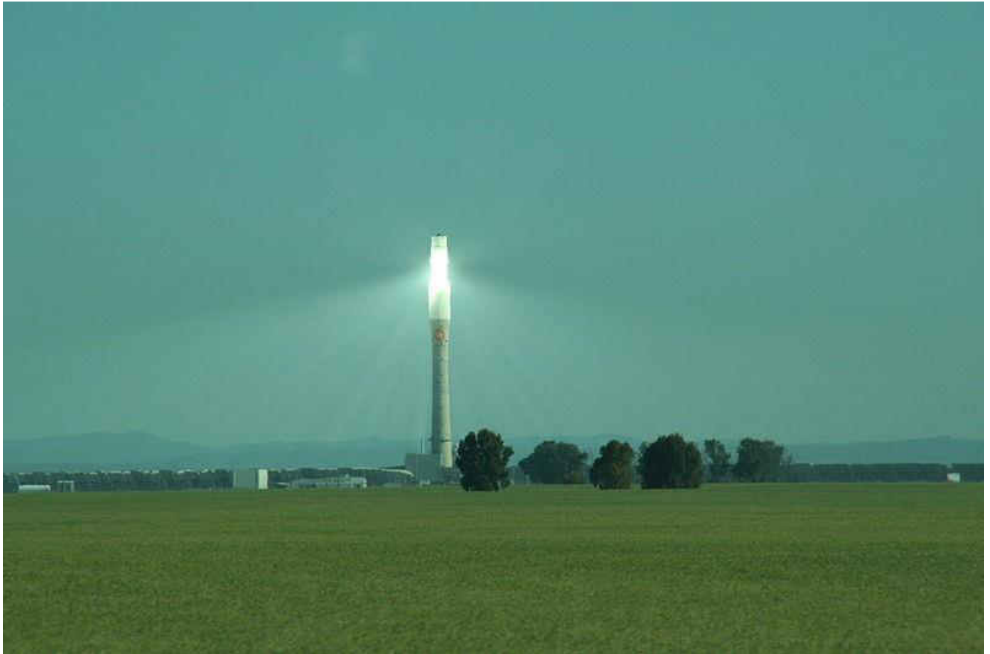
GEMASOLAR EN OPERACIÓN
