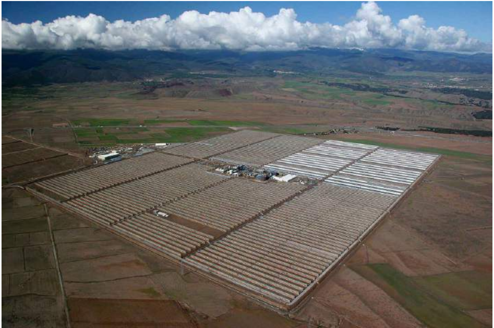
PLANTA TERMOSOLAR ANDASOL DE ESPEJOS PARABÓLICOS (150 MW), ESPAÑA. Utiliza un sistema de tanques con sales fundidas para almacenar el calor generado por la radiación solar, de forma que pueda seguir generando electricidad durante la noche.
