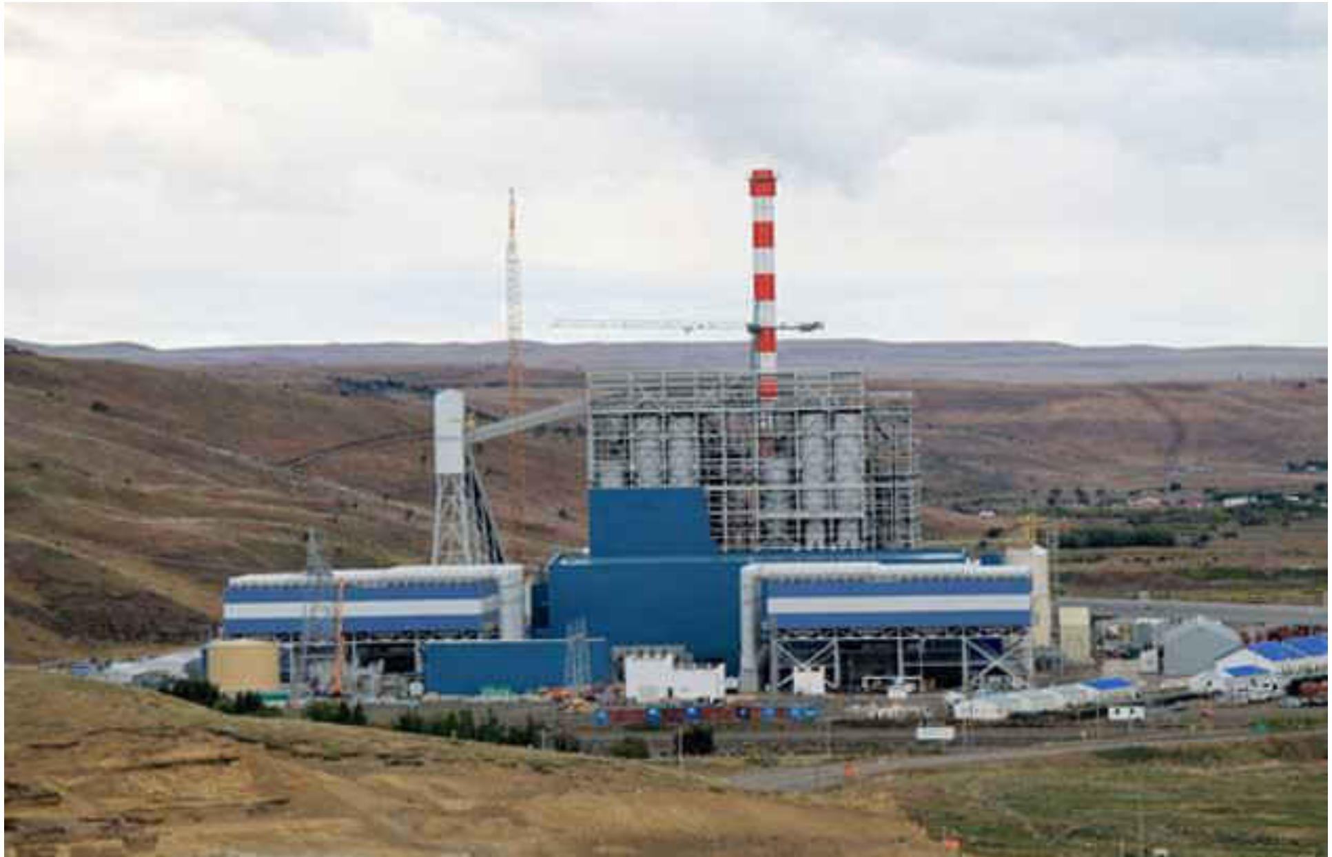
CENTRAL TERMOELÉCTRICA RÍO TURBIO SANTA CRUZ, ARGENTINA Combustible: Carbón. Potencia 240 MW
