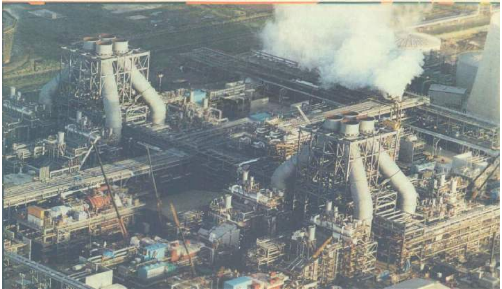
CENTRAL DE CICLO COMBINADO DE 1875 MW EN TEESSIDE, INGLATERRA
